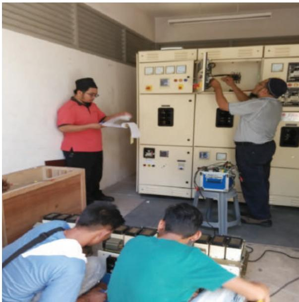
Kerja-kerja servis Air Circuit Breaker dan penentu ukur geganti dan peranti perlindungan.
