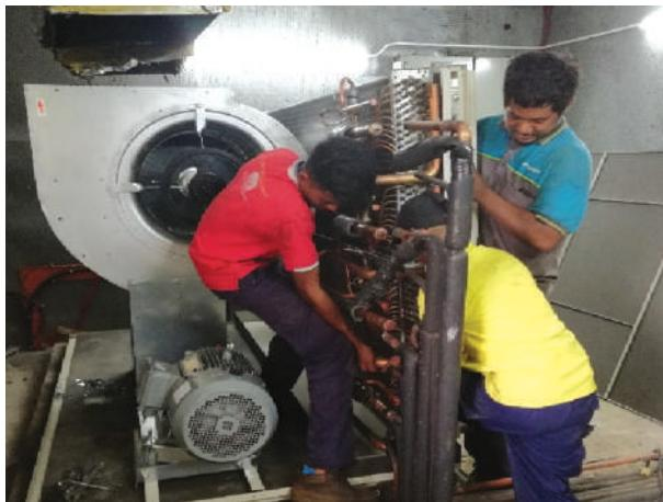
▶▶▶ Kerja-kerja membuka & memasang indoor AHU 500,000 btu di tingkat 2 & 3, Bangunan Utama, di Finas Hulu Kelang
