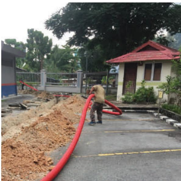
Kerja-kerja pengantian kabel elektrik bawah tanah dari bilik elektrik utama MSB ke bilik elektrik agihan SSB
